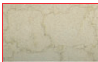
Dessin en tacheté dû aux impuretés dans le condensat de vapeur
