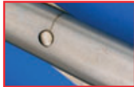
Fissure filiforme dans la zone du filetage de ciseaux
